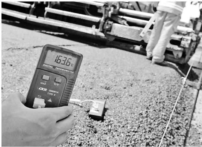
测温仪显示,刚摊铺的沥青路面温度高达163.6℃。
