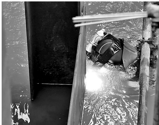
潜水员在水下焊接坝闸。
