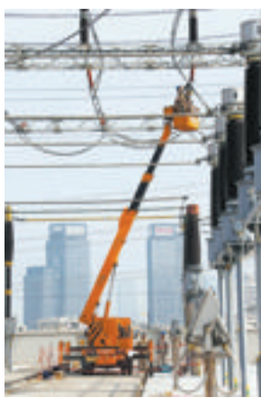
变电检修一班班员利用高空车进行导电回路维护。
